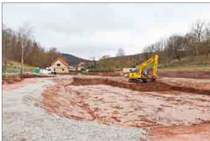
Eine zentrale, naturnahe Kläranlage für 500 Einwohnergleichwerte entsteht bei Birkenfelde.
