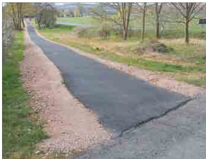
Der Weg vom Ort zum Friedhof wurde im Auftrag von Deuna Zement durch die Firma KEMNA BAU befestigt und in einen verkehrssicheren Zustand versetzt.
